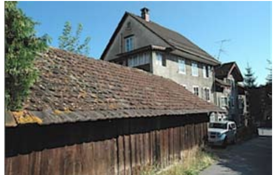
Die Liegenschaft Bergwerkstrasse 4 hätte Wohnraum für 5 bis 6 Haushalte ermöglicht.
